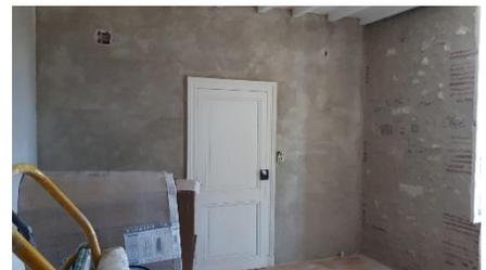
« Nous avons appliqué un minéralisant en bas des murs pour renforcer les tuileaux qui se réduisaient en poussières. Cette technique permet de les durcir légèrement pour que l'enduit tienne dessus. Pour résoudre le problème d'humidité, nous avons remplacé le mortier à base de ciment par de la chaux ; cela améliore naturellement la respiration des murs et permet ainsi de réguler l'hygrométrie. »
