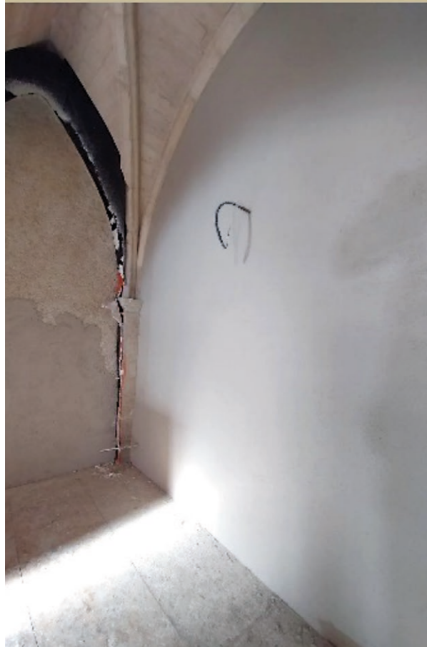
Application Naturlys sur béton de chanvre
